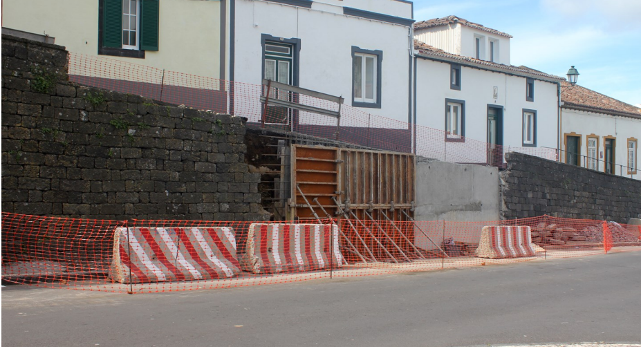
As obras decorrem a bom ritmo na Rua da Igreja, em Água de Pau.
